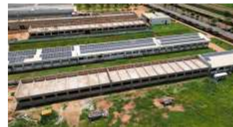
Figura 9 – Obra do PAC - Extensão do Bloco E
